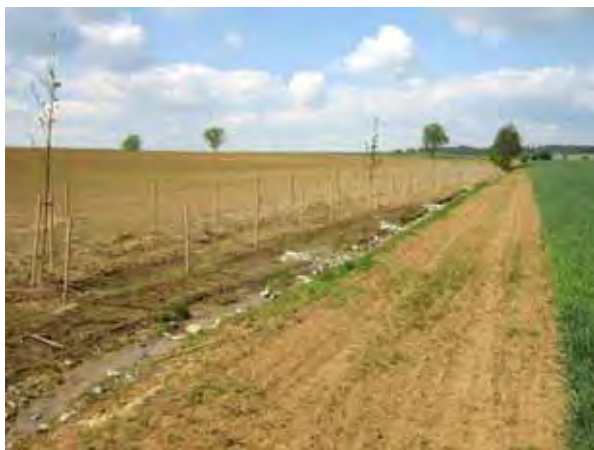
Beispiel Gewässerpflege: Irlbach bei Thalmassing vor und nach dem Ausbau.
