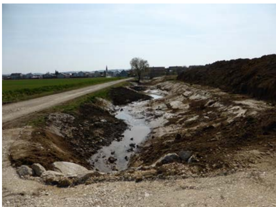
Ökologischer Gewässerumbau bei Pfakofen – Hochwasserrückhalt in der Fläche.
