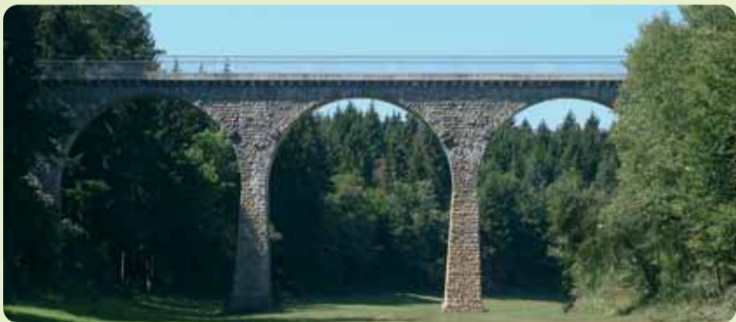
Die Hoibruck – ehemalige Bahnbrücke
