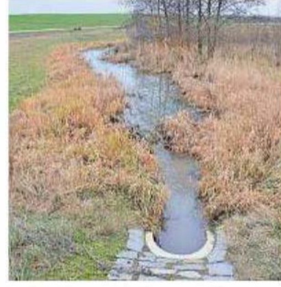
Bei Aufhausen hält ein gedrosselter Ablauf das Wasser zurück.
